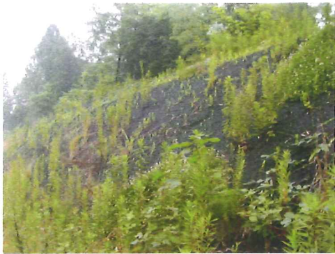
写真1 埋土種子の緑化に期待した法面の施工箇所の事例(今後の調査検討が必要)
