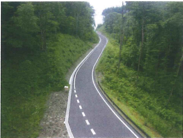
鍬木田一本木線完成状況
