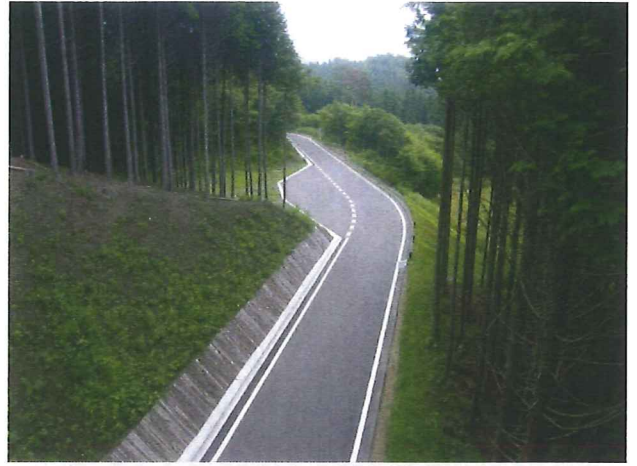
鍬木田一本木線完成状況
