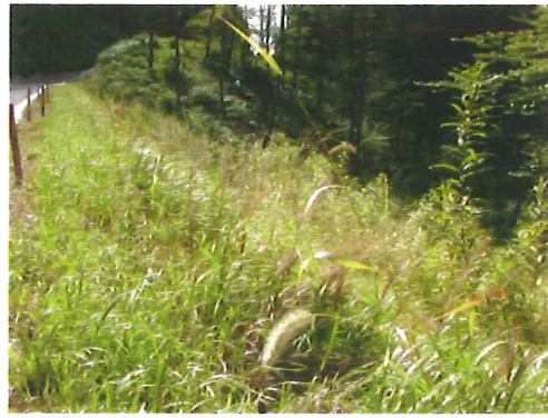
写真15 郷土種吹付施工6ヶ月後(左:切土面・右:盛土面)
