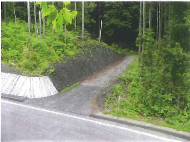
取付道路の設置状況
