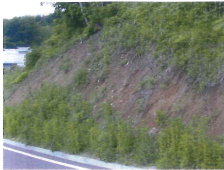
写真1 埋土種子の緑化に期待した法面の施工箇所の事例(今後の調査検討が必要)
