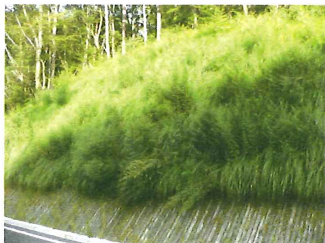
写真16 郷土種吹付施工18ヶ月後(木本類の進入・植生の遷移が確認できる)
