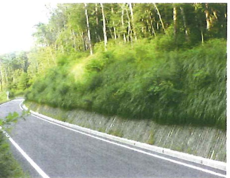
写真16 郷土種吹付施工18ヶ月後(木本類の進入・植生の遷移が確認できる)
