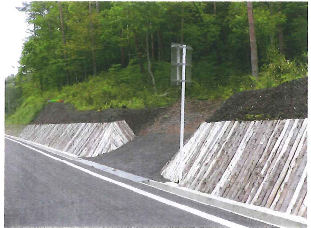
取付道路の設置状況
